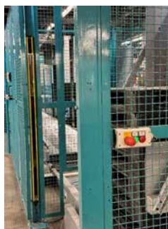
Voorbeelden van het toepassen van een lichtscherm (bron: Grafimedia)
